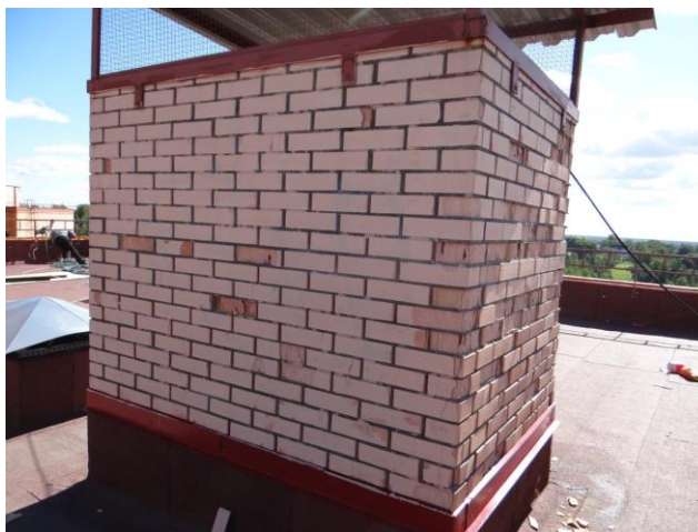
Рисунок 4. Деструкция кладки стен вытяжной шахты
