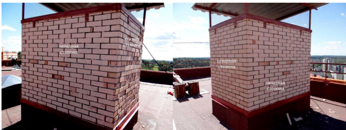
Рисунки 7, 8. Общий вид поврежденных стен вытяжной шахты. Деструкция кладки
