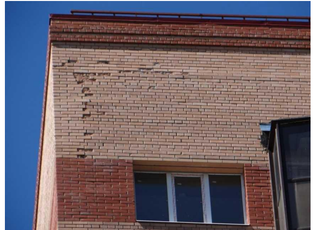
Рисунок 6. Деструкция кладки стен технического этажа
