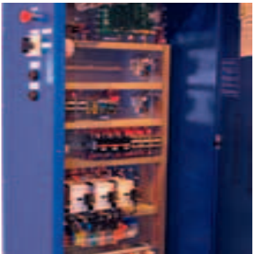
Контроллер и блок частотного регулирования в одном шкафу управления
