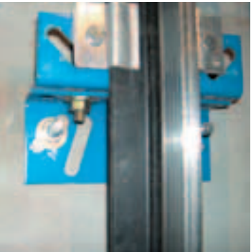
Кронштейн, обеспечивающий монтаж без закладных деталей
