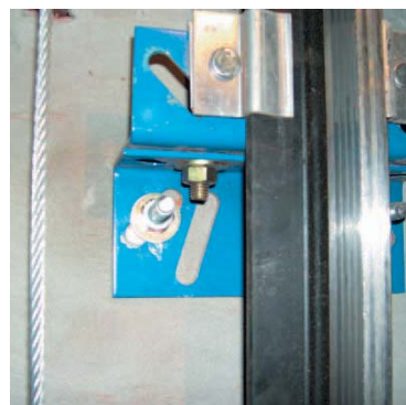
Кронштейн, обеспечивающий монтаж без закладных деталей
